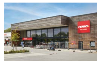
Einzelhandel Hochfelder Landstraße Flensburg
