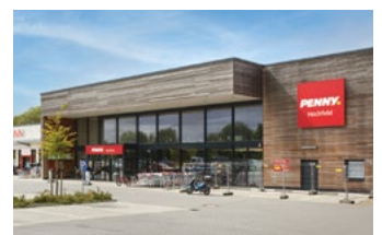
Einzelhandel Hochfelder Landstraße Flensburg
